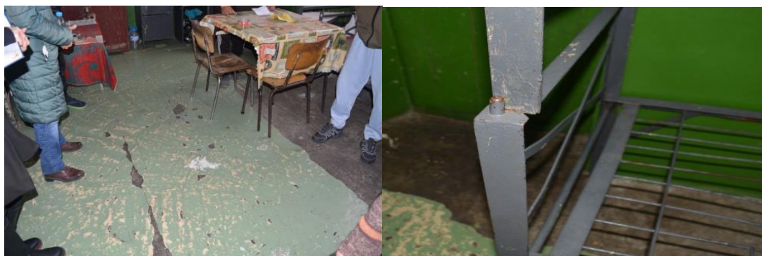
Бетонни подове в част от спалните помещения
